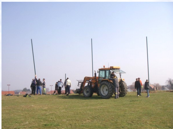
Pose de pax ballons Terrain de foot des Justices
