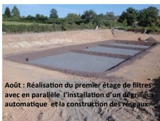
Août : Réalisation du premier étage de filtres avec en parallèle l'installation d'un dégrilleur automatique et la construction des réseaux
