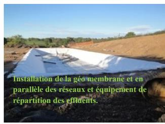
Installation de la géo-membrane et en parallèle des réseaux et équipement de répartition des effluents.
